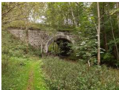
Bahnviadukt der ehem. Gußwerkler Strecke
